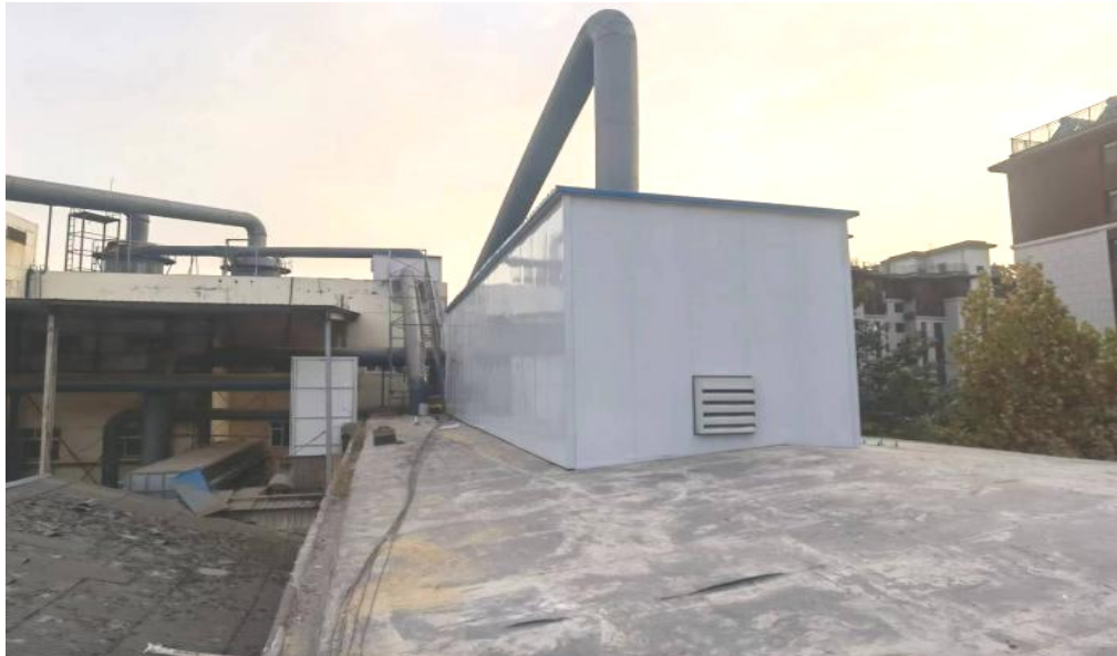
图 3-2 山东省潍坊市某企业除尘器加装隔声房
